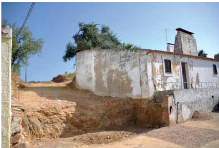
➤ Travessia pedonal entre a Quinta da Laranjinha e a Rua 1º de Dezembro, em Cabeção
