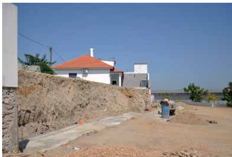
➤ Construção do muro de suporte de terreno, no Parque de Feiras de Mora
