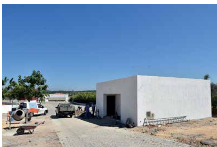
➤ Construção de novos sanitários no Parque de Feiras de Mora
