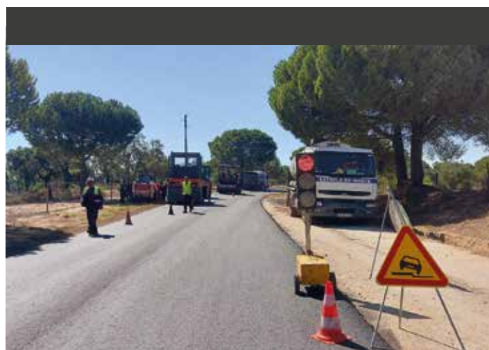
INTERVENÇÃO NO TROÇO N2 MORA - BROTAS
