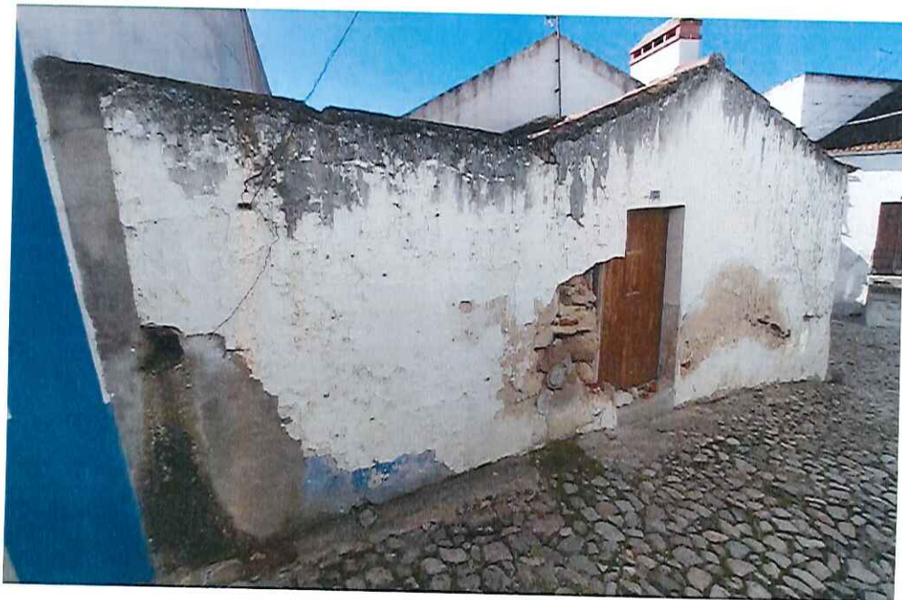
fachada lateral (norte)
