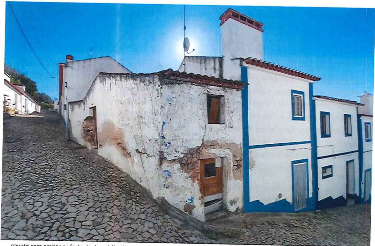
gaveto com ambas as fachada do prédio (Rua Joaquim Pereira Cachola)
