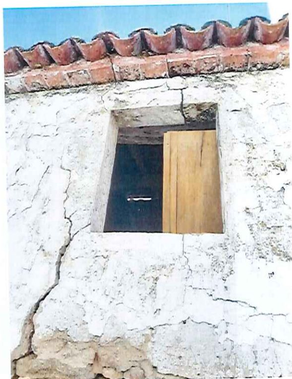
fissuramento profundo junto aos vãos exteriores
