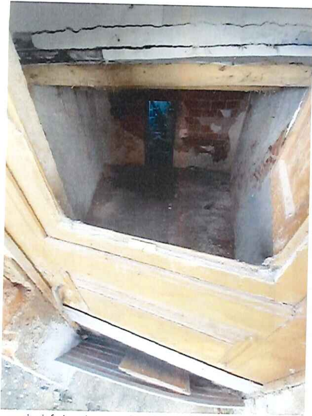
piso inferior, visto através da porta de entrada
