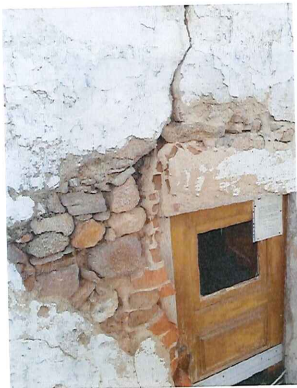
fissuramento profundo junto aos vãos exteriores
