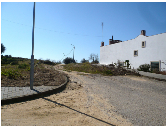
ARRUAMENTO DO LOTEAMENTO MUNICIPAL
